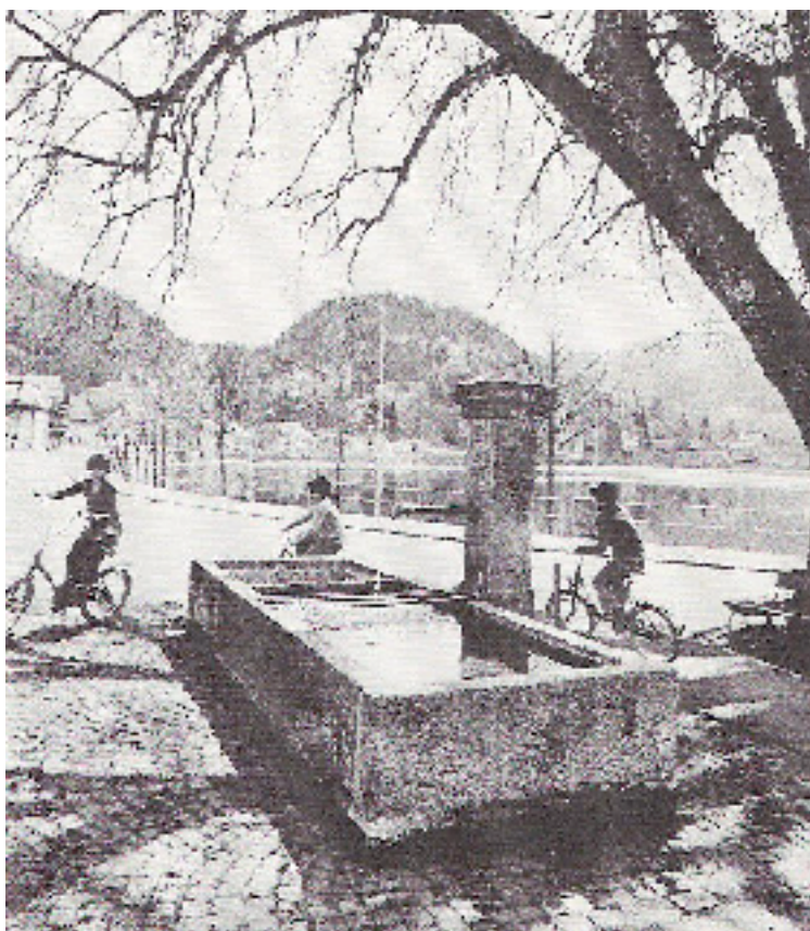
À La Vallée : Le Pont, fontaine de 1896, en plaques de Granit. (Paul Bonard, Fontaines des campagnes vaudoises)
